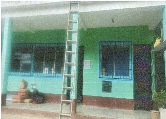
Foto 3: avance del mejoramiento del techo de patio
