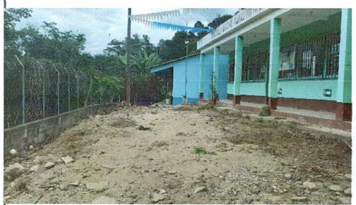
Foto 2: Avance del mejoramiento de piso
